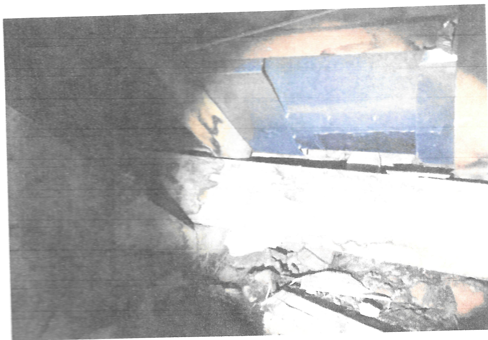
Imagem 6 – Como apresentado na imagem 5, houve um recorte indevido na calha no qual efetuaram uma emenda e colocaram isolamento porem por não receber manutenção a isolação perdeu efeito, deixando assim um alto volume de agua escorrer pela parede da escada.
