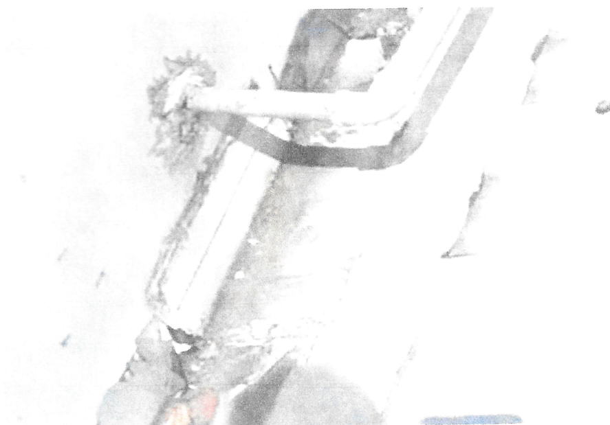
Imagem 4 – emenda com isolamento apresentando infiltração recorte indevido na calha
